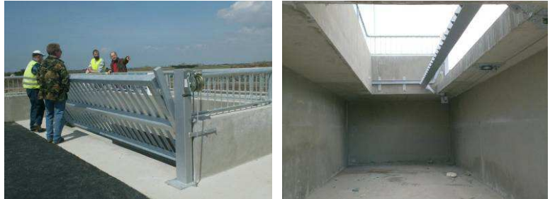
Figure 53 : Système de benne à gravats sous quai avec grille relevable sur la CC Océan Marais de Monts (85)
