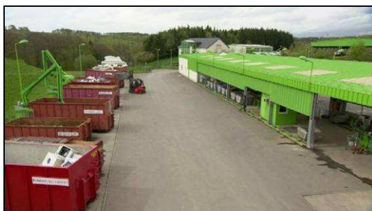
Figure 4 : Extérieur d'un parc à conteneur du SIDEK
