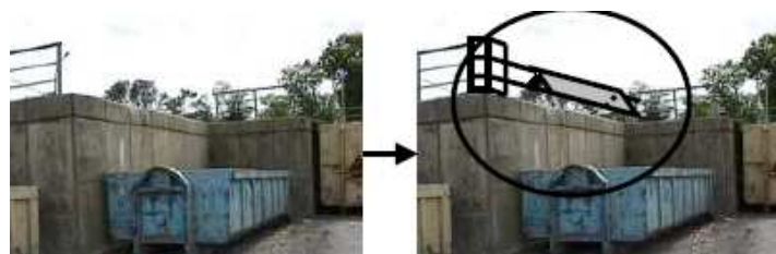
Figure 51 : Barrières de 0,90 m surmontées d'une plaque de déversement
