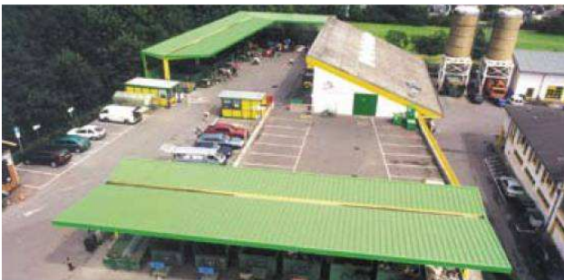
Figure 9 : Vue d'ensemble du site de Luxembourg
