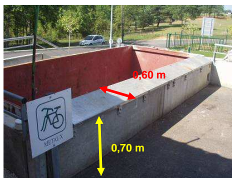
Figure 44 : Déchèterie d'Hautefort – SMCTOM de Thiviers (24)
