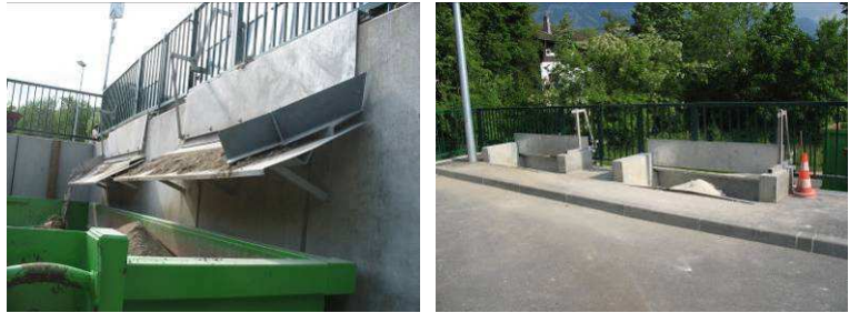
Figure 52 : Système de trémie de pré-vidage des gravats sur la CA du Lac du Bourget (73)
